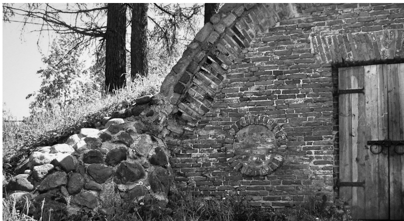
Павильон Кузница. Фрагмент фасада. Фотография автора. 2008 г.
